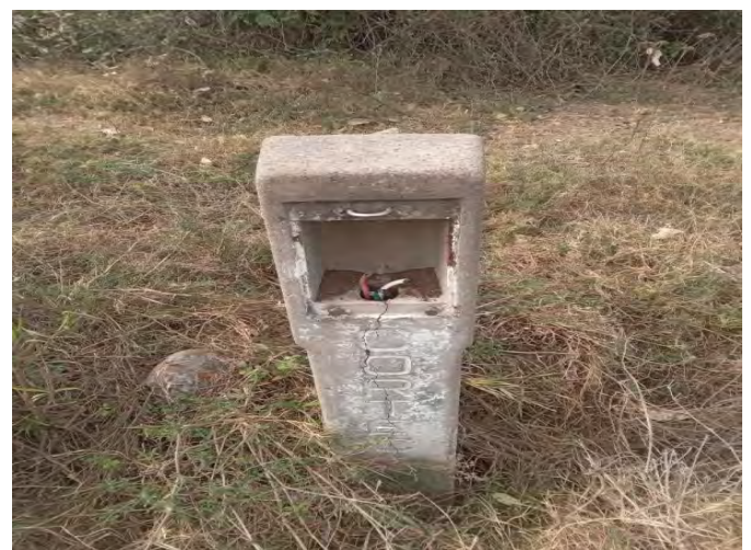
FIGURE 2 : CP TEST POST
