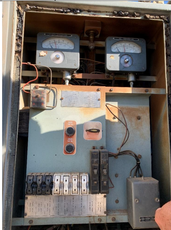
Tap changer marshalling kiosk
