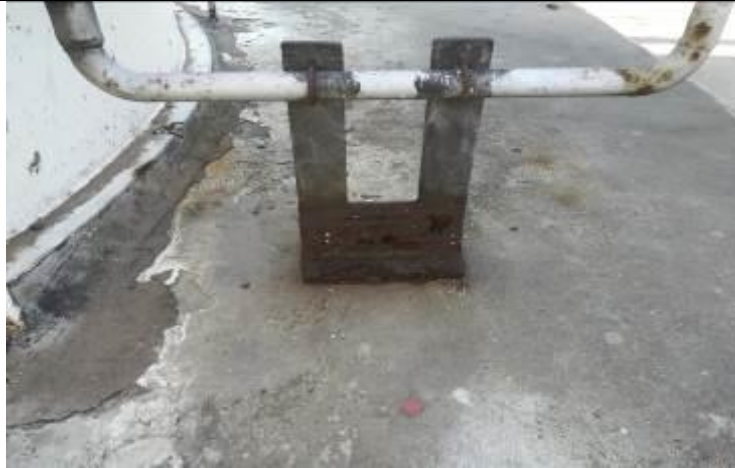
Rusted thermal relief plinth
